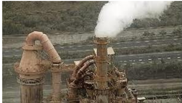
Fábrica actual (junto la A3)
