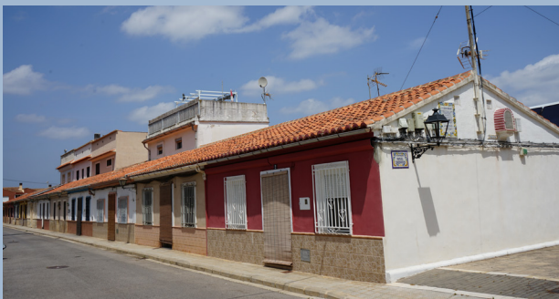
Imatge actual de les Vivendes Casesnoves, grup d'autoconstrucció en cooperativa per 24 famílies necessitades d'habitatge, 1960-61.
