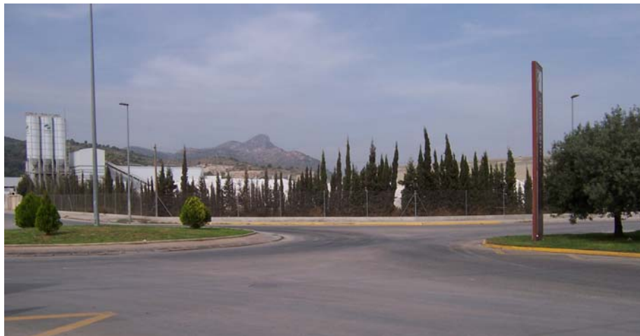
Rotonda sin ningún tipo de señales viales, tanto verticales como horizontales
